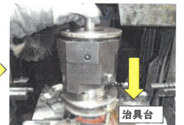
ホイストを設置し、吊上げてセットする
